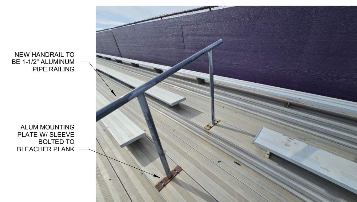
A6 EXISTING GUARDAIL MOUNTING A-103P 1/8" = 1'-0"
